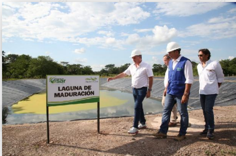
Agustín Codazzi. (Alcantarillado Sanitario de Llerasca) Inversión: $ 4.110 millones
