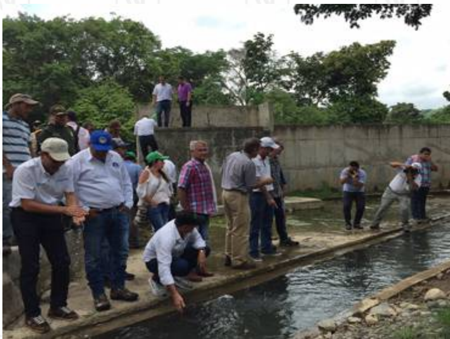
Rehabilitación de 5 minidistritos de riego
