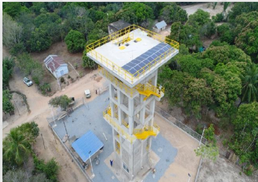
Chimichagua - Optimización del sistema de acueducto en Soledad. Inversión: $ 3.363 millones
