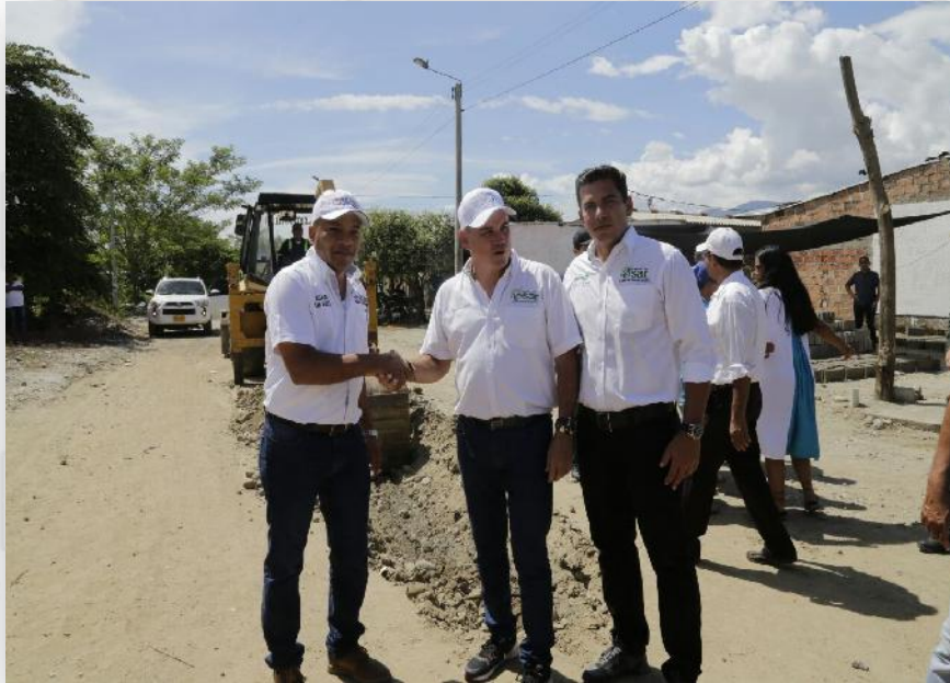
San Alberto - Alcantarillado sanitario Inversión: $ 11.100 millones
