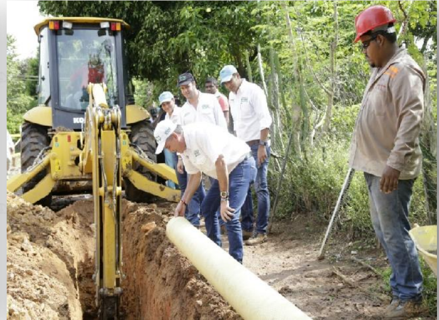
Pelaya - sistema de acueducto y alcantarillado sanitario de Costilla. Inversión: $ 4.988 millones
