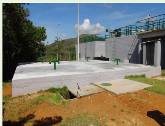
Fotografía N° 04. Optimización Sistema de Acueducto. Población beneficiada: 4.484
