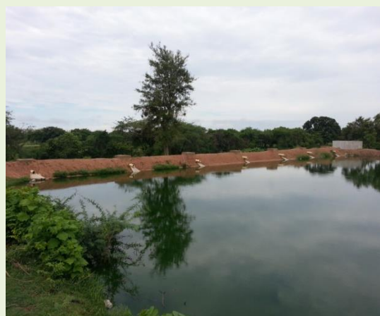
Fotografía N° 02. STAR El Paso Población beneficiada: 3.915
